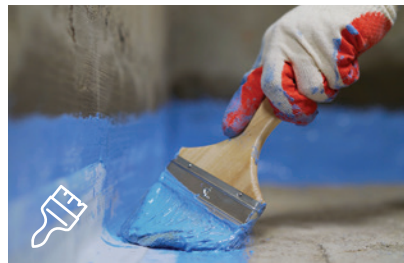
수작업(브러쉬, 롤러, RAKE 작업) 프로텍 NP-200(BR-H)
